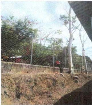
Aquí se observa el desgaste del muro, lo cual representa peligro.
